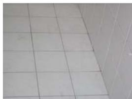
Tutti i locali della zona giorno saranno pavimentati con mattonelle di ceramica monocottura di prima scelta nel formato di cm 30x30, o similare, del prezzo d'acquisto di € 10,35 il m<sup>2</sup>, posati a correre con fughe accostate.
