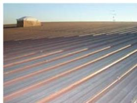
Il manto di copertura sarà costituito da lastre in alluminio grecato e preverniciato di colore a scelta della D.L., posate su appositi listelli in legno fissati al tavellonato sottostante.
