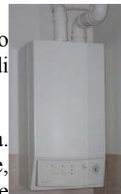
La caldaia del tipo a doppio uso, produrrà l'acqua calda per le apparecchiature sanitarie.
