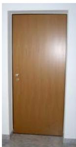
I portoncini di accesso agli alloggi saranno del tipo blindato con chiusura di sicurezza, completi di cornici, di coprifili e con specchiatura interna rivestita da pannelli in noce Nazionale oppure laccati bianco.
