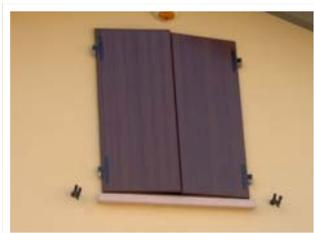
Le imposte esterne delle finestre e delle portefinestre saranno realizzate con scuri in alluminio preverniciato di colore a scelta della D.L.
