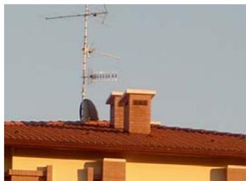
L'impianto di ricezione TV è unico per la palazzina ed è costituito da un'antenna centralizzata per la ricezione dei canali RAI e di 5 canali privati, con predisposizione del centralino per aggiunta di ulteriori canali privati compreso filtri per la visione dei canali digitali.
