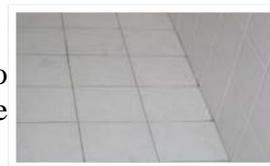
Tutti i locali della zona giorno saranno pavimentati con mattonelle di ceramica monocottura di prima scelta nel formato di cm. 30x30 o similare, del prezzo netto di acquisto di €10,00 il mq., posate in diagonale con fughe.
