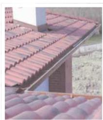
Il manto di copertura sarà eseguito con tegole in cemento colorato o similare. Lungo la linea di colmo del tetto verrà posto in opera un numero adeguato di punti sicuri di ancoraggio in acciaio inox, predisposti per il collegamento con una fune in acciaio inox il tutto nel rispetto delle norme UNI EN 795.
