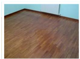
Le camere da letto saranno pavimentate in legno con listelli di cm. 5/6x20/30x1 di Iroko levigato e verniciato o del tipo prefinito a scelta della D.L.
