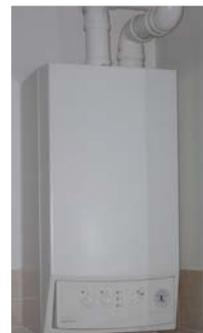
La caldaia del tipo a doppio uso, integrerà a norma di legge la produzione di acqua calda per le apparecchiature sanitarie derivante dall'impianto solare, calcolato per la produzione del 50% del fabbisogno.
