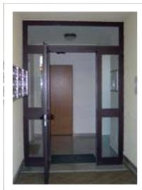
Il portoncino principale di accesso al fabbricato verrà realizzato con profili in alluminio preverniciato con vetri stratificati, completo di elettroserratura, di pompa per la chiusura automatica, di maniglione e tutto quanto necessario al buon funzionamento.
