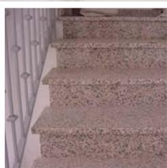
Le scale saranno costruite in cemento armato, rivestite con alzate e pedate in granito Rosa Porrino o similare, mentre i pavimenti degli ingressi comuni, i pianerottoli ed i battiscopa saranno realizzati con mattonelle di gres porcellanato. Le ringhiere dove necessarie saranno realizzate in ferro verniciato a semplice disegno con corrimano in legno di iroko o similare.
