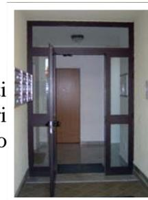
I portoncini principali di accesso ai vani scala, verranno realizzati con profili in alluminio preverniciato completo di elettroserratura, di vetri stratificati, di pompa per la chiusura automatica, di maniglioni e tutto quanto necessario al buon funzionamento.
