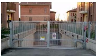
Il cancello dell'accesso carraio, verrà realizzato in ferro zincato e preverniciato a semplice disegno, con apertura del tipo a due ante completo di motorizzazione elettrica con comando a distanza (1 ogni alloggio).
