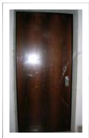
I portoncini di accesso agli alloggi saranno del tipo blindato con chiusura di sicurezza, completi di coprifili e con specchiatura interna ed esterna liscia rivestita da pannelli in noce Nazionale o similare.
